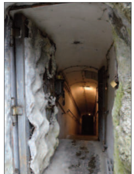
Gang im Bunker
