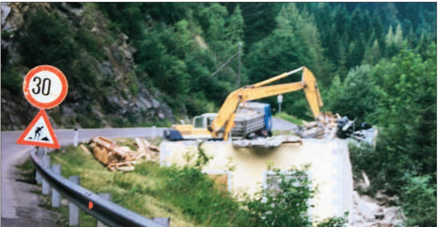
Hier stand das Kraftwerkshaus mit der Hausnummer Sillianberg 1. Das Bild zeigt den Abriss vor 20 Jahren (1999)
