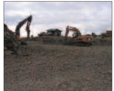
Hier entsteht die Bergstation
