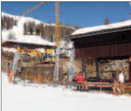
Lifebetrieb und Grundaushub im März
