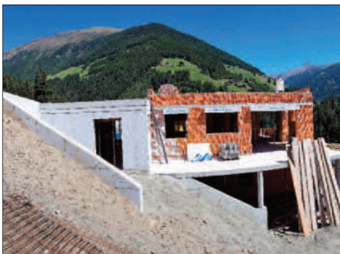
Neubau Einfamilienwohnhaus Mühlmann Markus, HNr. 194
