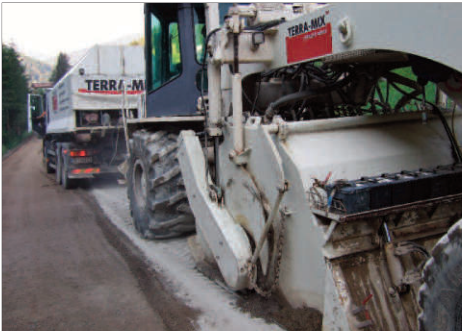
Fräsmaschine bei Arbeit Sanierung Gemeindestraße Hinterwinkelal
