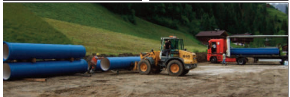
Wasserkraftwerk Winkeltal - Spatenstich und Baufortschritt
