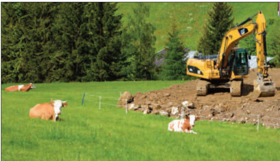
Das Weidevieh widmet dem Fotografen mehr Aufmerksamkeit als der Baustelle für die Wasserfassung KW Winkelthal
