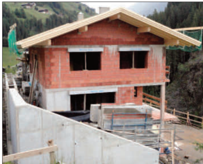
Neubau Einfamilienwohnhaus Trojer Annemarie und Obetzhofer Josef, HNr. 182
