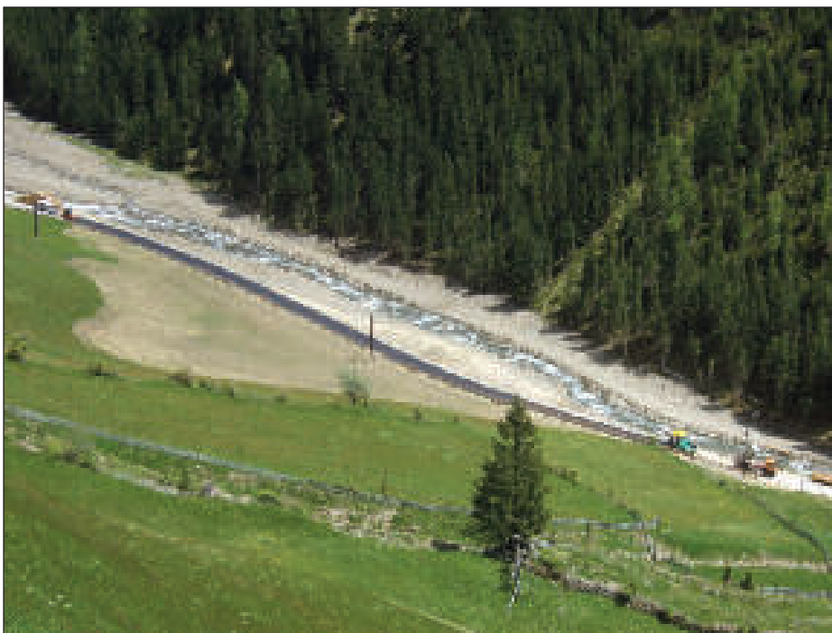
Sanierung und Asphaltierung Winkeltalstraße
