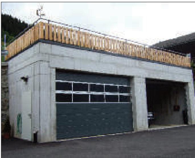
Abbruch und Neubau Garage Walder Franz, HNr. 25
