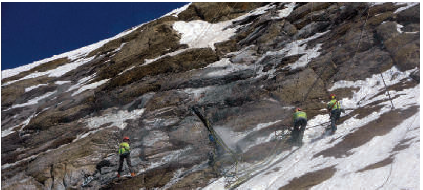
Installation einer Bohrlochinstrumentierung am Kitzsteinhorn, Hohe Tauern – Quelle: alpS
