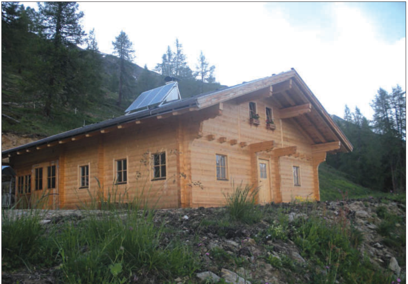
Neubau komb. Algebäude Mair Leonhard, HNr. 66
