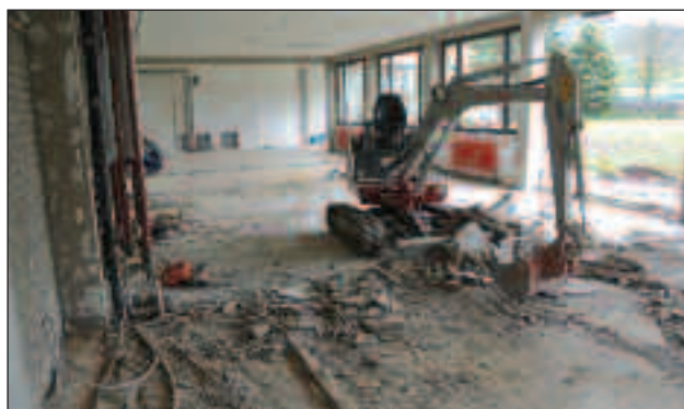
Ebene 0 (vorher Kellerbereich) wird umgebaut
