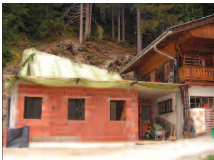
Aufstockung Wohnhaus Weitlaner Werner, HNr: 5
