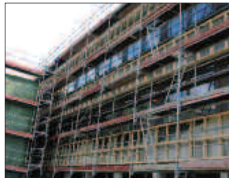
Arbeiten an der Außenfassade im Westen
