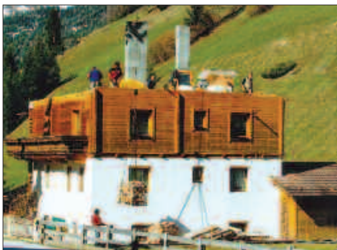
Erneuerung und Erhöhung des Dachstuhles Pirgler Franz, HNr: 123
