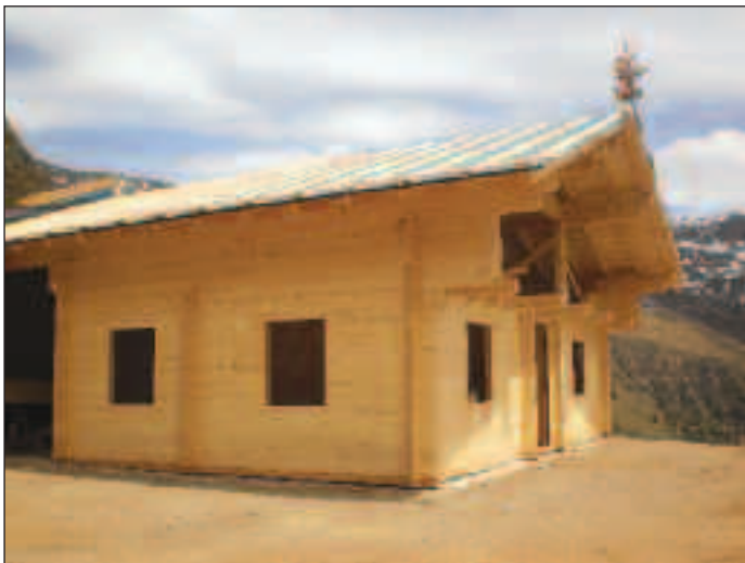
Neubau komb. Alpegebäude, AG Heimkaralpe, Obm. Kraler Franz, 9913 Abfaltersbach 64
