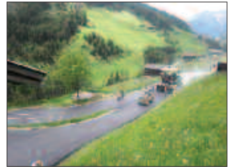
Fertigstellung der Weganlage Hochkofel
