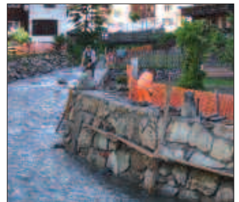
Hochwasserschutz im Dorf Fotos (2): Gemeinde
