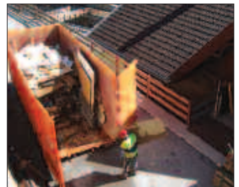
Entrümpelung in der Alten Schule als Vorarbeit zum Wohnbau
