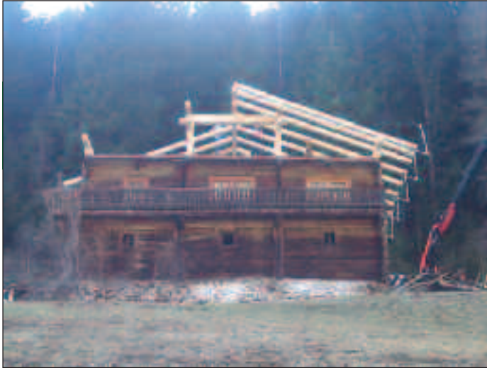
Erneuerung Dachstuhl beim Trojhäusl, Ortner Franz, Trojhäusl HNr. 9b
