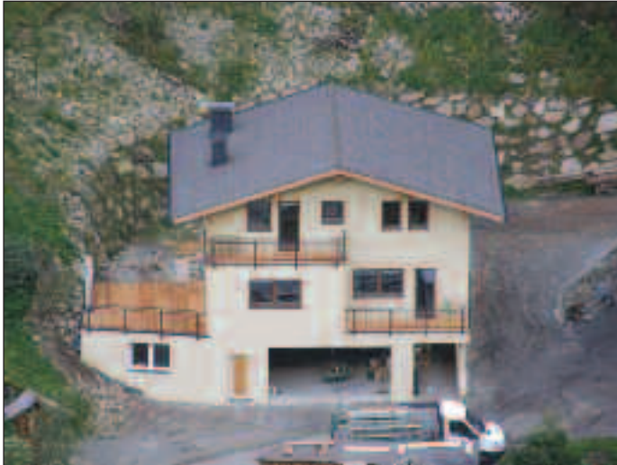
Neubau Einfamilienwohnhaus Bergmann Josef, HNr: 142a
