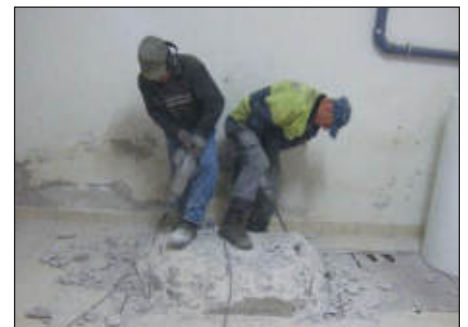
Schreumarbeiten im Keller des Gemeindehauses
