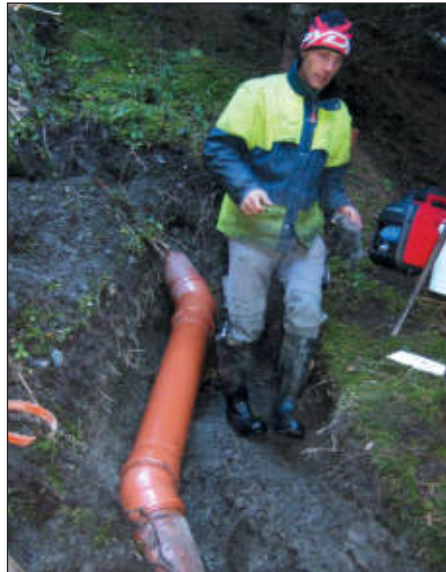
Sanierung von Rohrschäden
