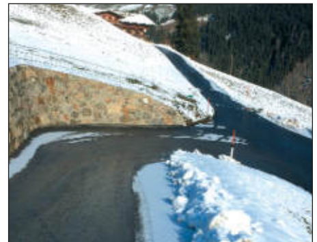
Sanierung Straße Hinterunterwalden
