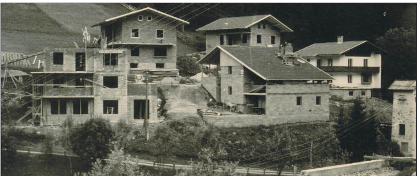
Die untere Kirchensiedlung wird im Niederbruggerfeld gebaut, August 1968
