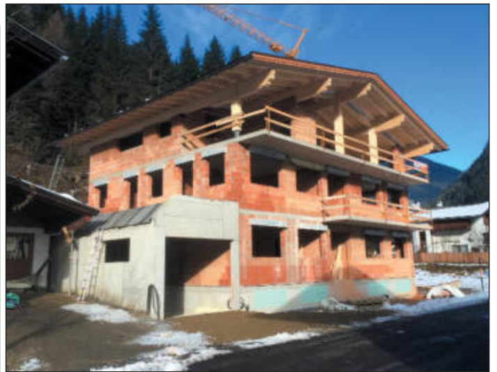
Andreas Gardener, Aue, Neuerrichtung Wohnhaus
