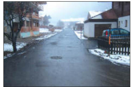
Sanierte Weanlage Aigenau
