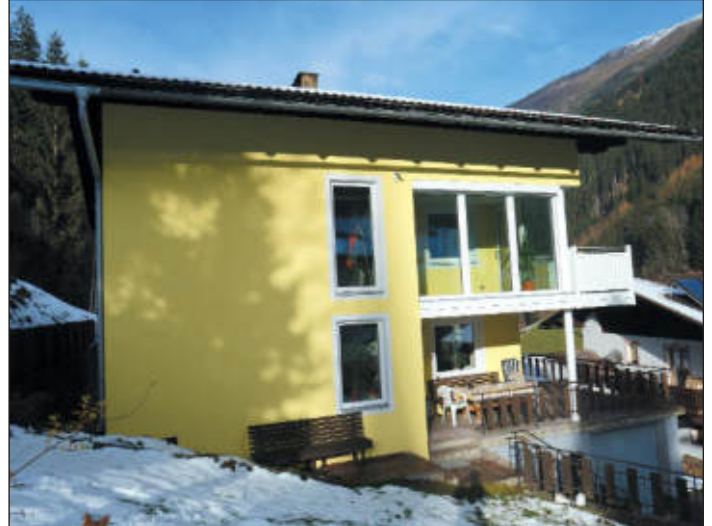
Errichtung Wintergarten sowie diverse Umbauarbeiten im Obergeschoß des Wohnhauses Ing. Perfler Arnold, HNr. 173
