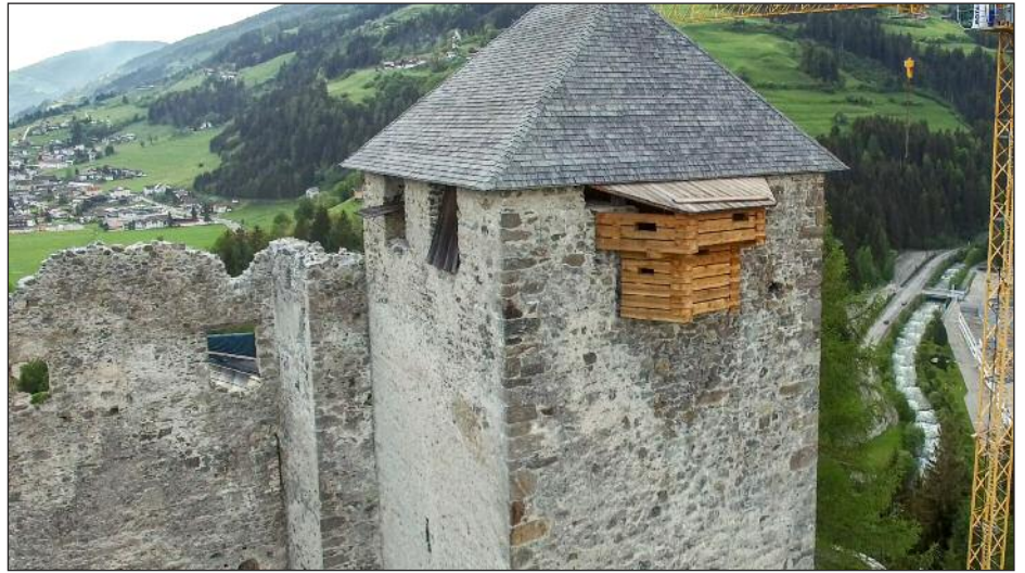
Der 20 Meter hohe Bergfried der Burg Heinfels mit seiner neuen „Nase“: Eine Rekonstruktion eines Wurferkers mit Schießscharten, der vermutlich im 16. Jahrhundert errichtet wurde, aber nicht lange das Erscheinungsbild des Turmes prägte.
