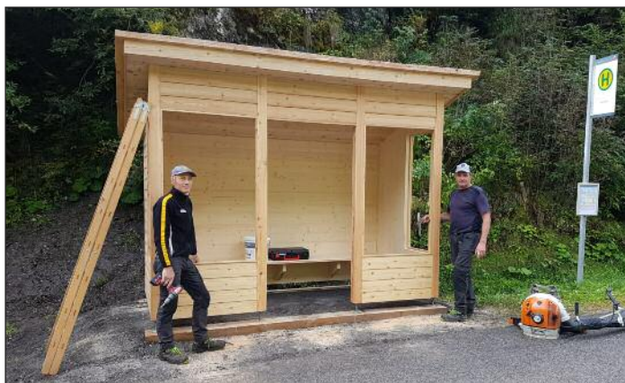
Wartehütte bei Talet Nr. 63
