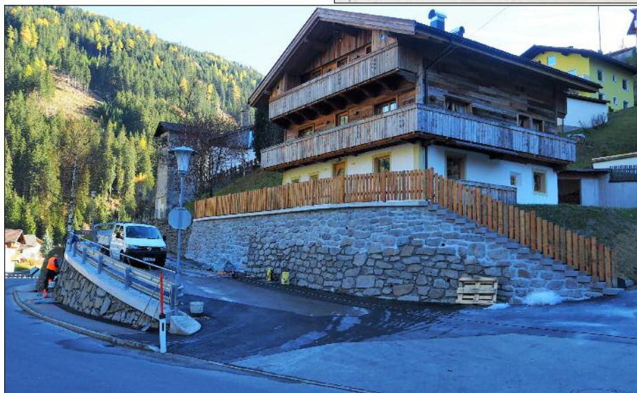
Mündungsbereich Gemeindegang Stiner Zeine wird sicherer
