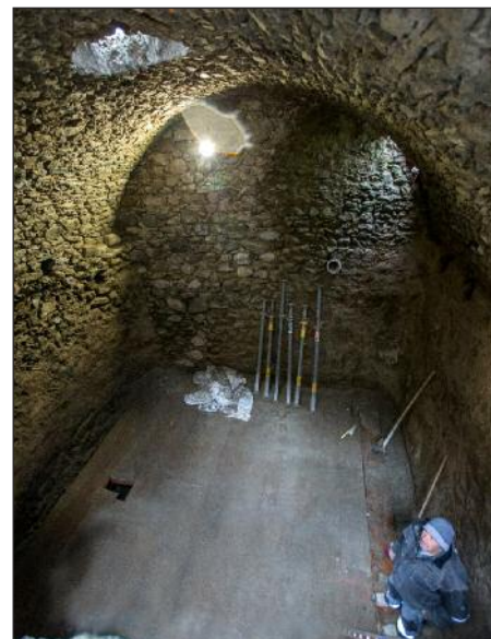
Im 16. Jahrhundert wurde die alte Zisterne mit einem Fassungsvermögen von 90.000 Litern bereits als baufällig beschrieben. Nun ist sie nach originalem Vorbild wiederrichtet worden.
