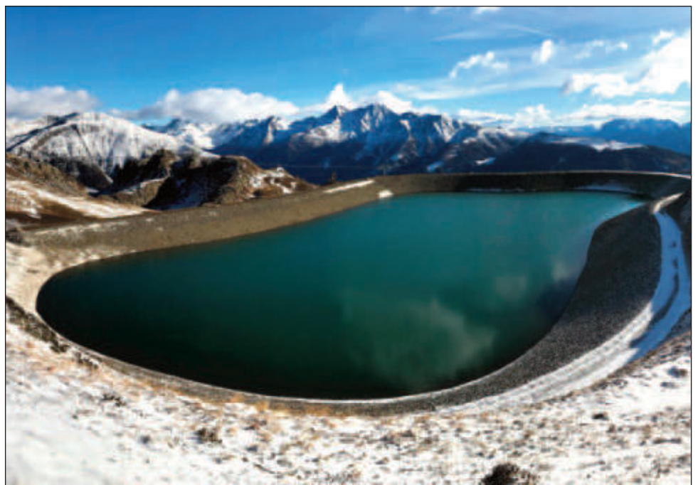
Ausgrabungsarbeiten und fertiger Speicherteich
