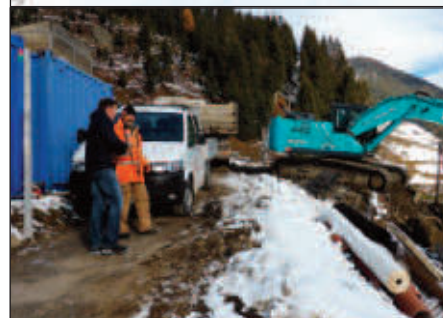
Bauarbeiten an der Zufahrt Neugereuth
