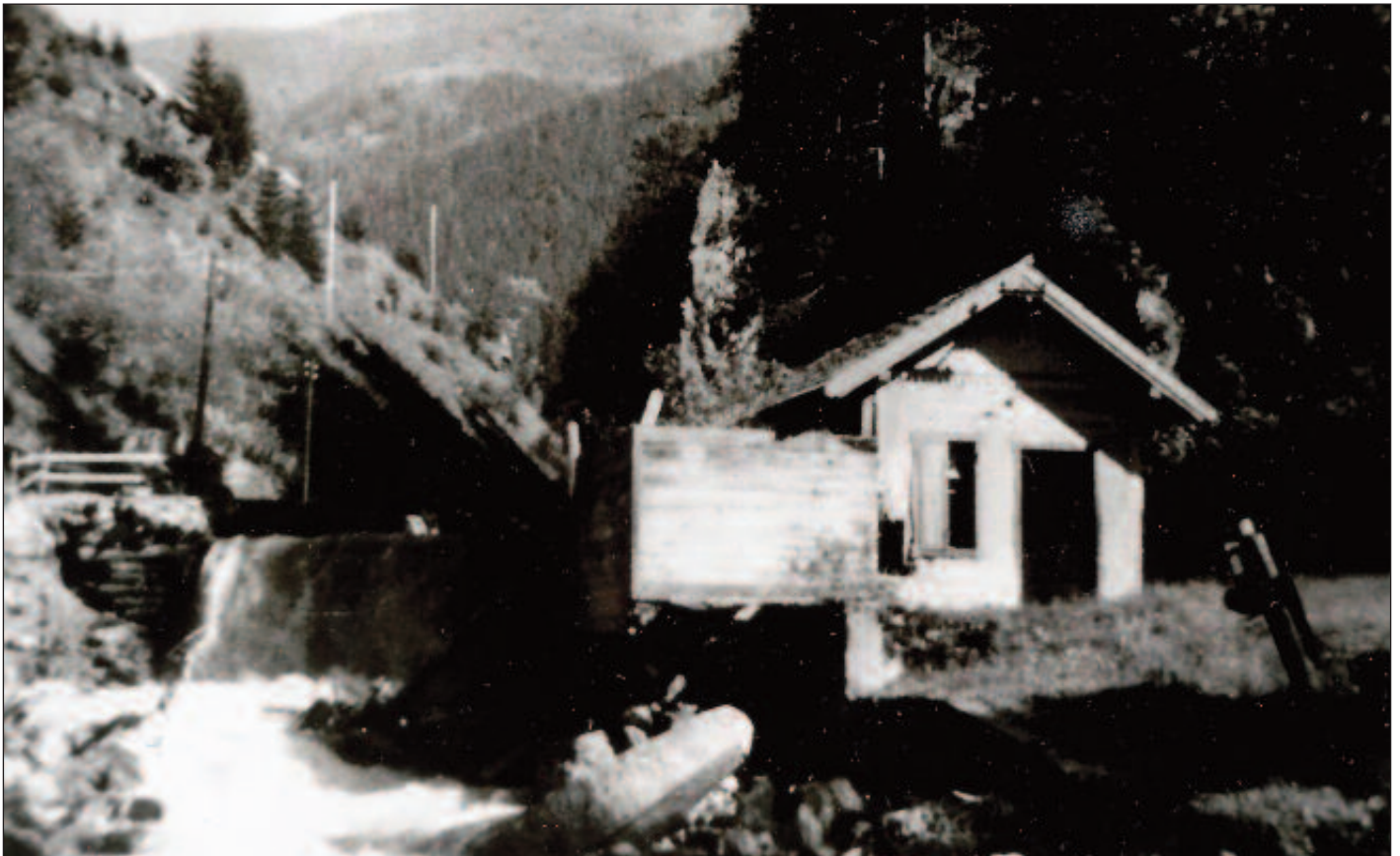
Im Winkeltal gab es bereits ein Kraftwerk. Die Aufnahme zeigt das alte E-Werk des Gutsbesitzers Anton Leiter nach der Hochwasserkatastrophe 1965/66
