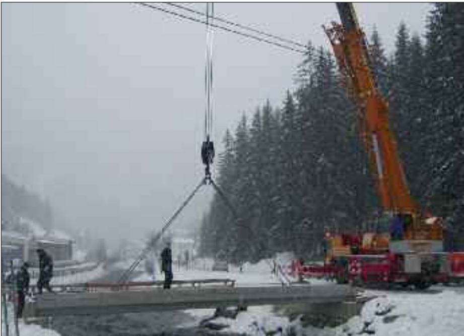
Brücke Unterkofl wird erneuert
