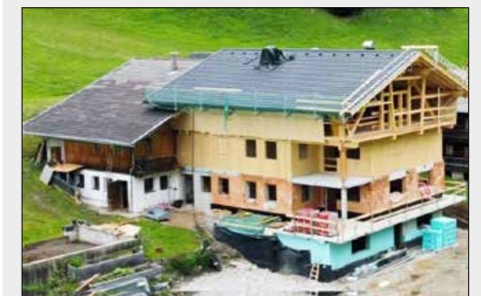
Mag. Mair Josef, HNr. 112 Abbruch und Wiederaufbau bzw. teilw. Umbau
