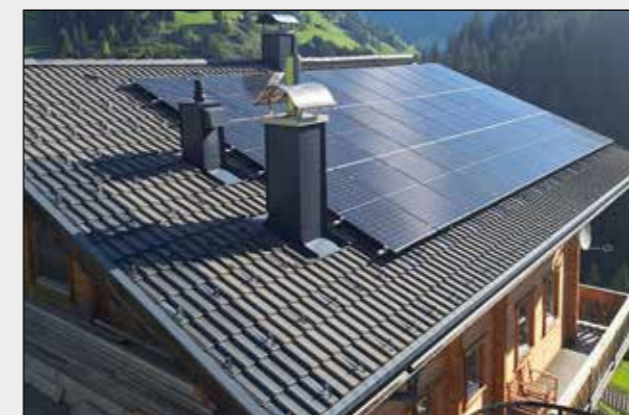
Mair Franz, HNr. 263 Errichtung einer PV-Anlage
