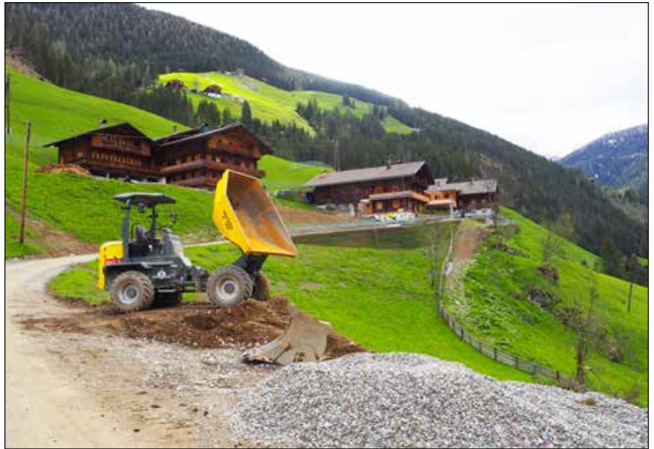
Bauarbeiten bei der Zufahrt Rennlahn-Lungkofel
