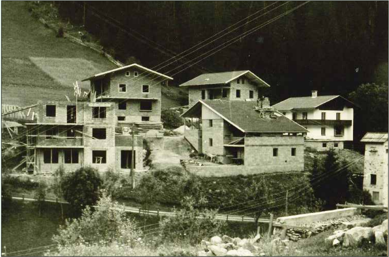
Die untere Kirchensiedlung wird im Niederbrugger Feld gebaut, August 1968.
