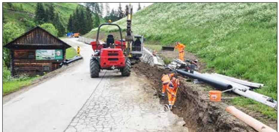
Arbeiten an der L326 Winkeltalstraße
