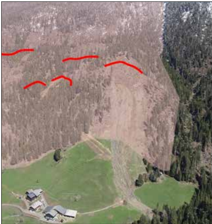
Überblick der Großmassenbewegung „Gabesitten“ (rote Fläche). Am Fuß des Talzuschubes kommt es zu mehreren Rutschereignissen (Anrisse = rote Linien).
