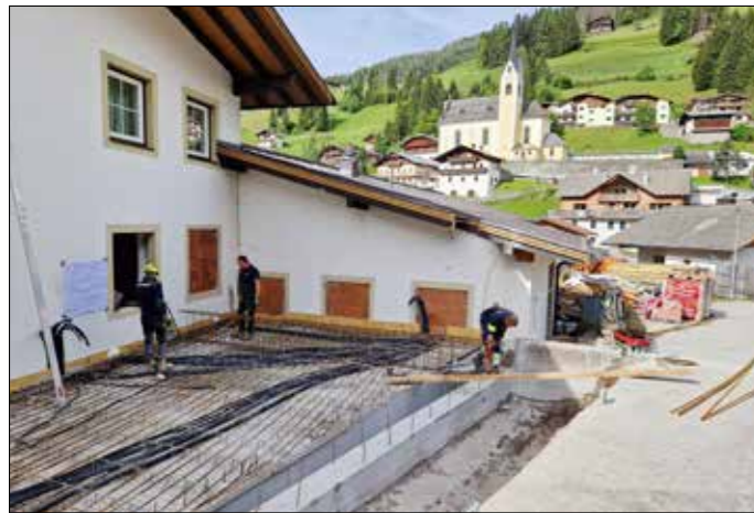
Fertigstellung des Bauvorhabens „barrierefreie Erschließung von Gemeinde und Volksschule“
