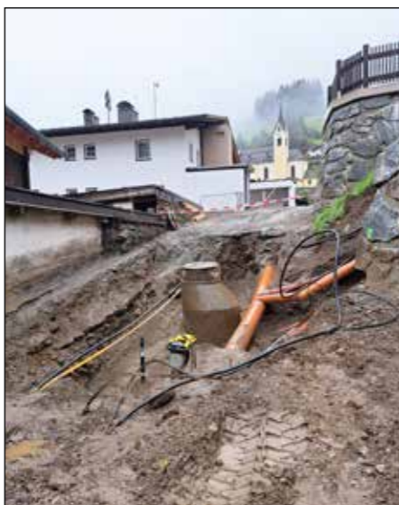
Besonders herausfordernd bei Straßensanierungen sind die im Straßenkörper liegenden zahlreichen Leitungen, so wie hier im Bereich des Gemeindehauses in Außervillgraten.
