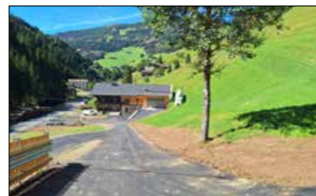
Baulich adaptierte Hofstelle „Außernefe“ mit umgebauter Zufahrt. Fotos: Agrar Lienz
