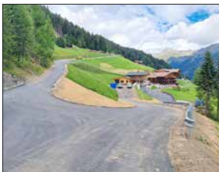
erfreulicherweise heuer baulich fertiggestellt werden.
