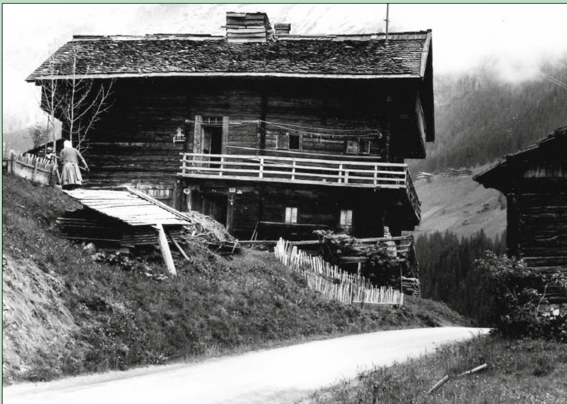
Haus Ahrn in Hinterunterwalden (Mellitzer) als Querflurhaus über Gebrente aufgebaut, Originals Hausgartl unten und oben Dachhaube für Seiltransmission. Foto: Hansl Trojer, 1974
