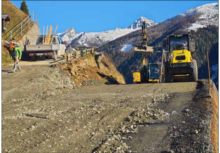
Beginn Güterwegbaustelle Versellerberg, Abzweigung Brandhöfe
