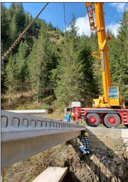
Neues Stahlbetontragwerk an der Rennlahnbrücke
