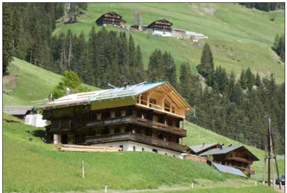
Zahlreiche private Bautätigkeiten bei den Hofstellen an der Straße Rennlahn-Lungkofel.
