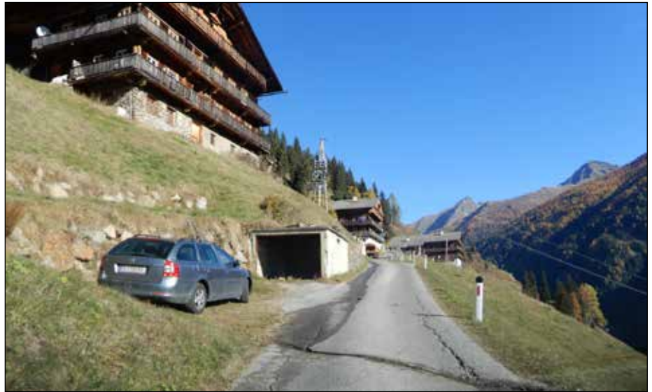
Straßenschäden im Bereich der Egarthöfe/Versellerberg
