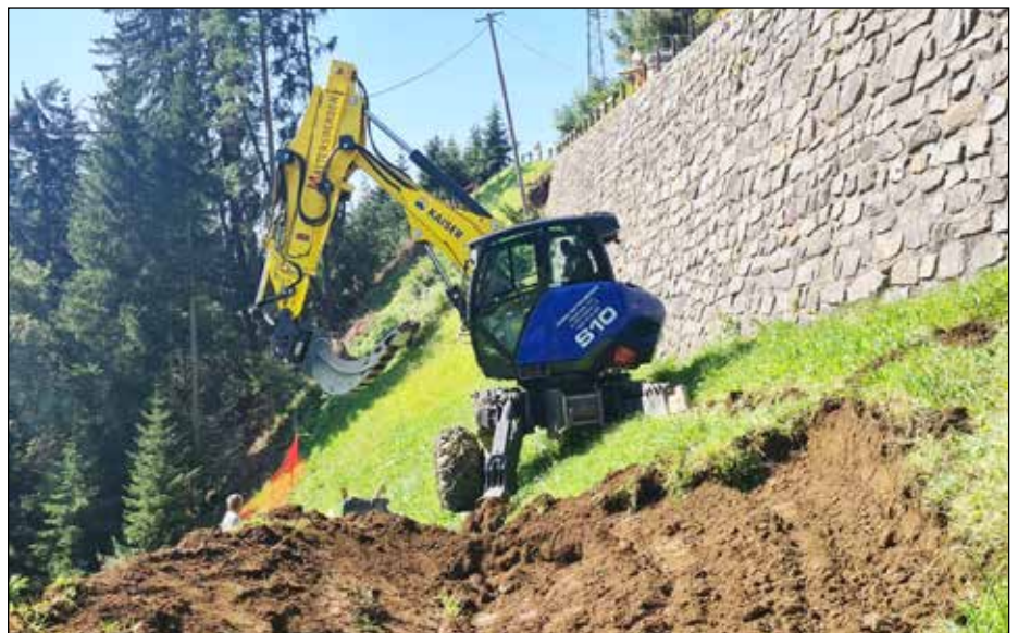
Mitverlegungsbaustelle LWL und Stromleitung im Bereich Neugereuth
