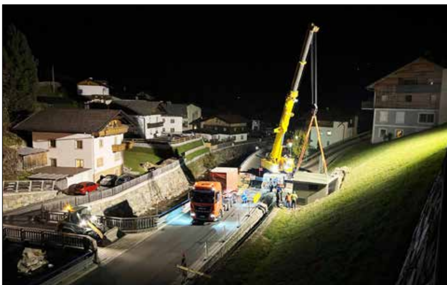
Versetzung der Trafostation
