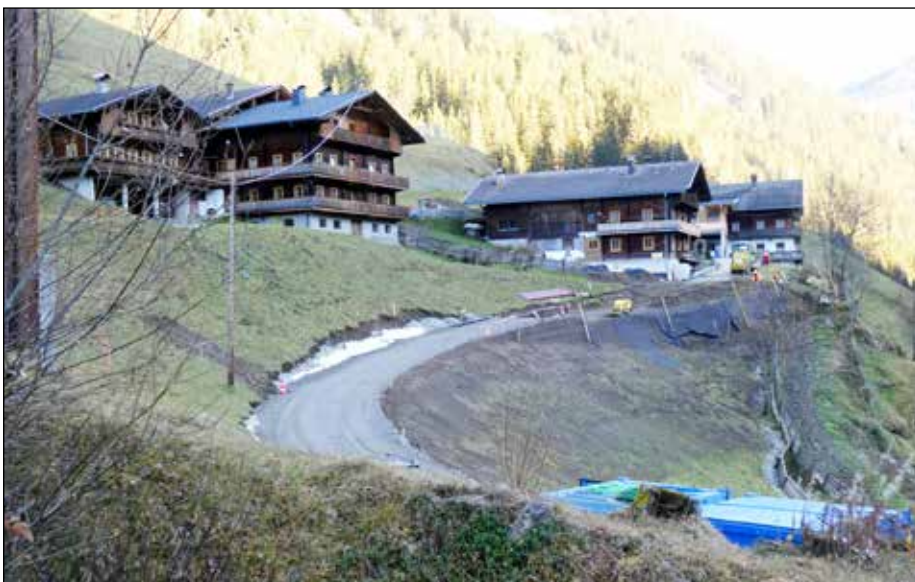
Baufortschritt Mitte November 2020
