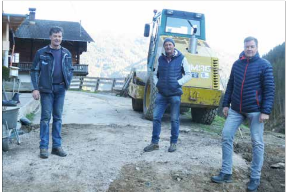
Wegobmann Heinrich Bachmann (links) macht sich gemeinsam mit Bauführer Josef Walder (Mitte) und Amtsleiter DI Hubert Mühlmann (rechts), beide von der Agrar Lienz, ein Bild von den Bauarbeiten.
