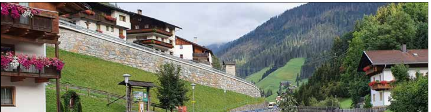
Gemeindeweg "Stiner Zeine" wurde zeitgemäß ausgebaut und gestaltet
