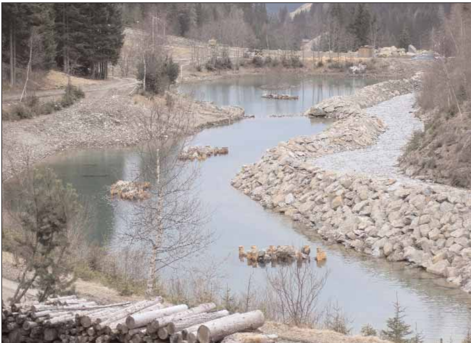
Rückbau des Ausschotterungsbeckens Tilliachbach
