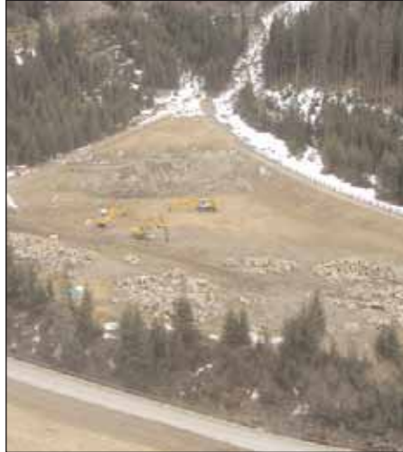
Baggerarbeiten am Tilliachboden
