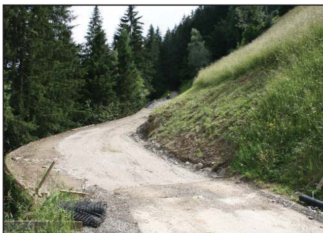
Die Stöcklstraße wird im Bereich der „Honsn-Tiefe“ saniert
