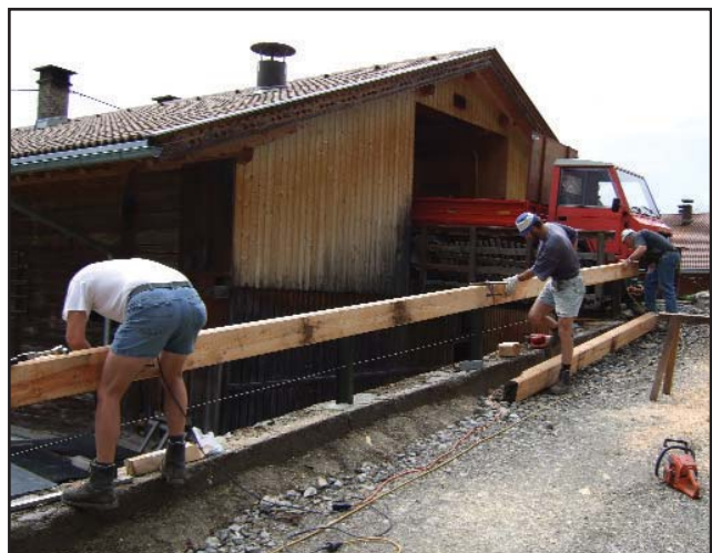
Ausbau der Straße der Weggemeinschaft Außerunterwalden beim Hause Walder-Mossmann Foto: Josef Mair
