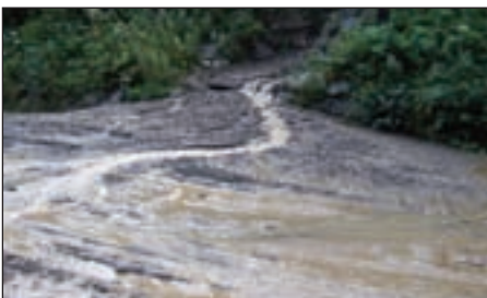
Straßenverlegung beim Stanabachl im Winkel- tal Fotos: Leonhard Trojer
