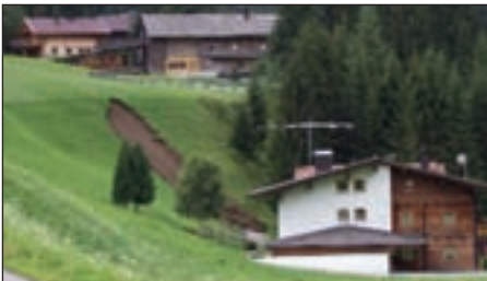
Hangrutschung Untermoos im Walchboden
