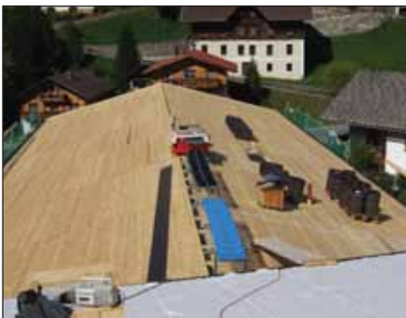
Dachsanie rung Schule und Gemeindehaus
