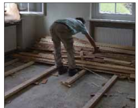
Sanierung einer Wohnung im Gemeindehaus
