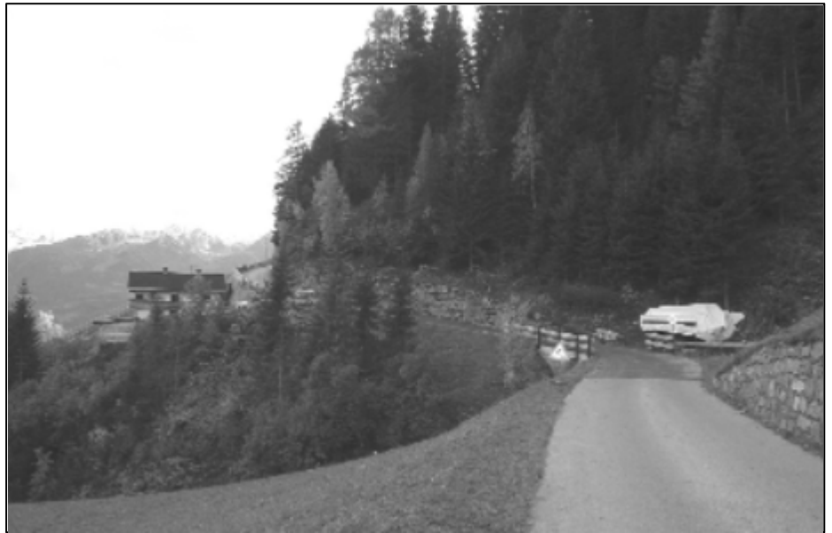
Im heurigen Jahr saniertes Straßenabschnitt des Güterweges Breitenbach.
