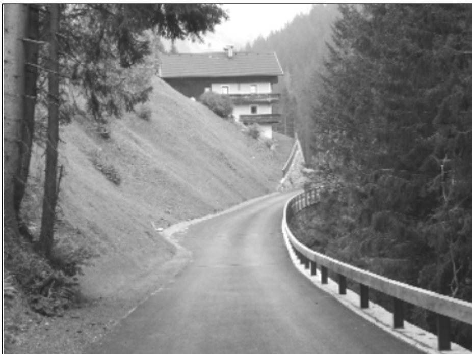
Fertiggestellte Stöckelstraße im Bereich „Unterahrn“
