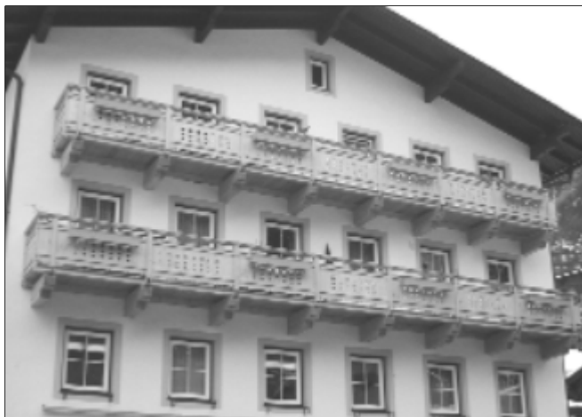
Nach 40 Jahren wurden die Balkone des Gemeindehauses erneuert
